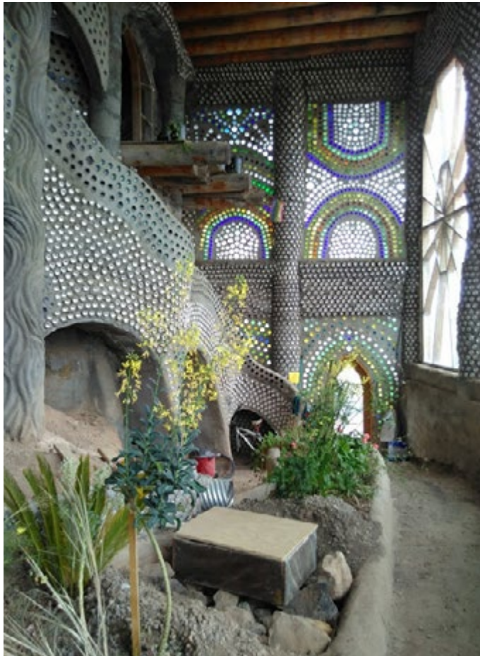
Utilisation de bouteilles et cannettes en construction
