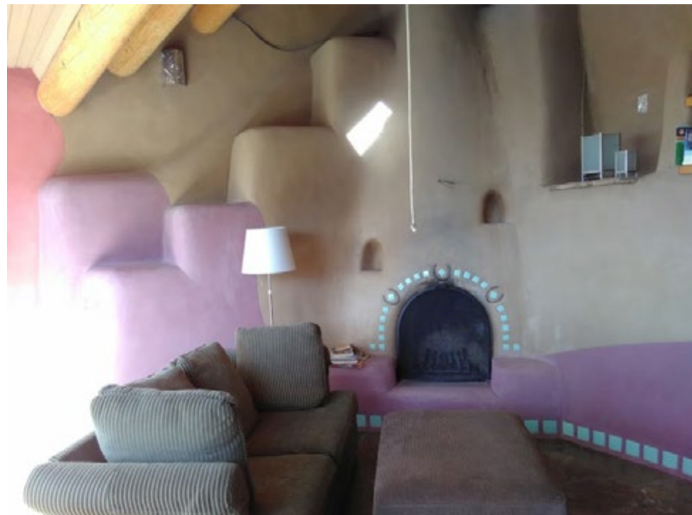
Mur pneu recouvert d'un enduit en argile
