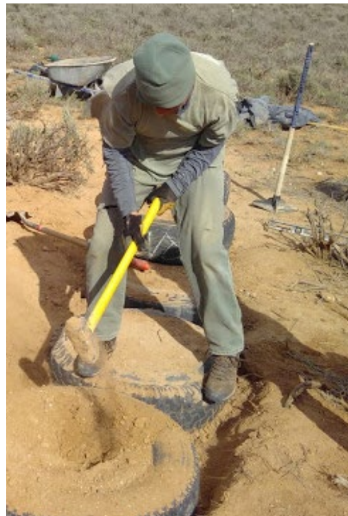
Remplissage et tassement du pneu à la masse
