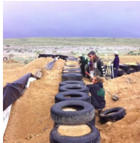
Élévation du mur en pneu étage par étage
