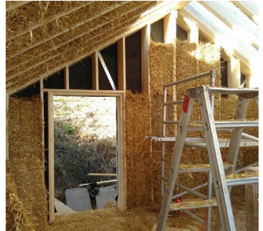
Isolation en paille d'un bâtiment à Grandevent (VD)
